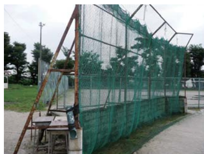
運動場バックネットの鉄骨
