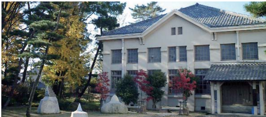
改修工事のうえ保存される旧講堂
